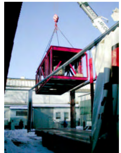
Verladen einer Schleuderplatte
