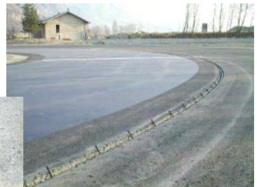
Verlegung der Kreisbahnsegmente
