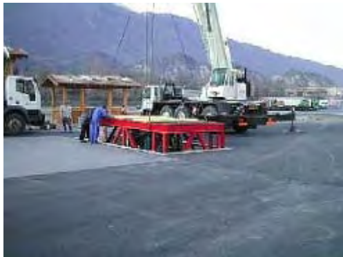
Einbau einer Schleuderplatte
