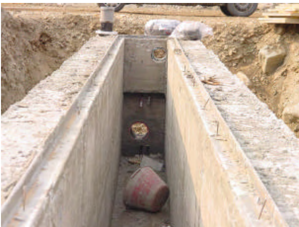
Die Betonwanne eines Hindernisses
